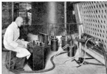
Ein Kessel wird geröntgt.
